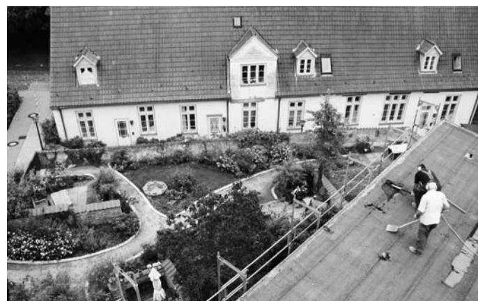
Die Nachbarn profitieren: Der Anbau, der ihren Garten überragte, wurde Stück für Stück abgerissen
