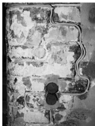
Eingepasst: Stromkabel verlaufen in den Mauerfugen...
