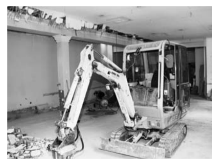
Der Bagger musste auf engstem Raum arbeiten
