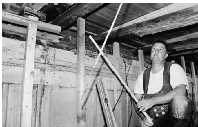
Stabilisiert: Zimmermann Jules Denton begutachtet Stahlprofile und verstärkte Holzbalken. Die Bretterwand zum Gang wird verschalt
