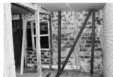
Die Stahlstreben verschwinden noch hinter einer Trockenbauwand
