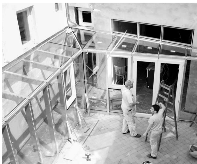
Durch die neue Verglasung kommt das Licht auch in den Schankraum
