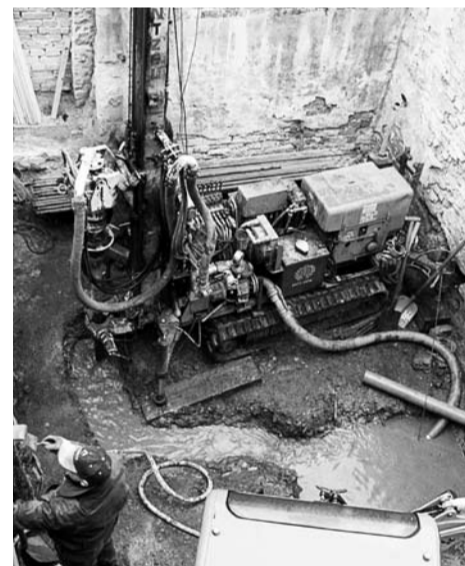
Mit einem Spülbohrkopf arbeitet sich die Maschine bis in 80 Meter Tiefe vor
