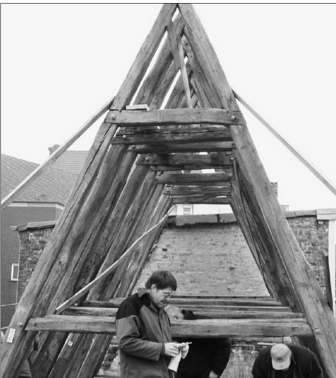
Die gerettete Dachkonstruktion konnte bereits wieder aufgesetzt werden
