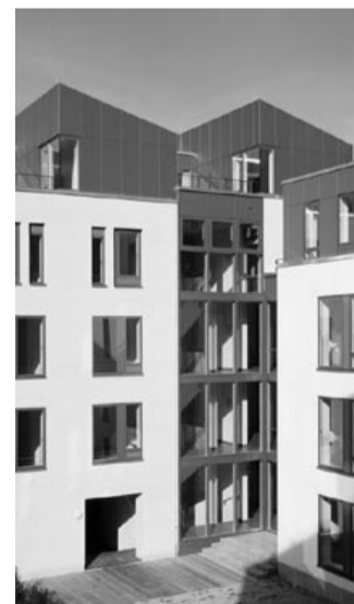
Dachterrassen und Glasfronten öffnen sich zum Innenhof des Internationalen Studentenwohnheims
