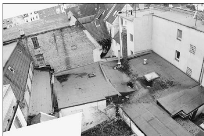
Vor dem Abriss: Das baufällige Lagergebäude füllt den Innenhof aus
