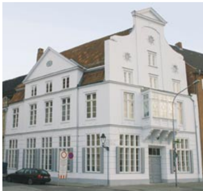
Die Barockfassade des Hauses ist klassizistisch überformt. Seit der Sanierung ist der Eingang wieder mittig, die Symmetrie wiederhergestellt
