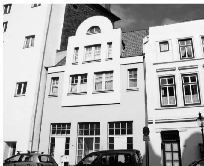
Mit dem Haus Engelsgrube 80 schloss die »Trave« 1986 eine Baulücke
