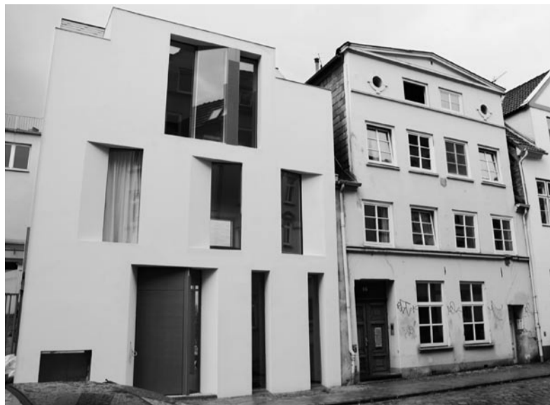
Die bodentiefen Fenster des Neubaus sorgen für viel Licht
