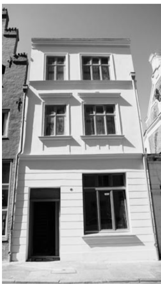
Wiederhergestellt: Die Fassade erstrahlt in neuem Glanz
