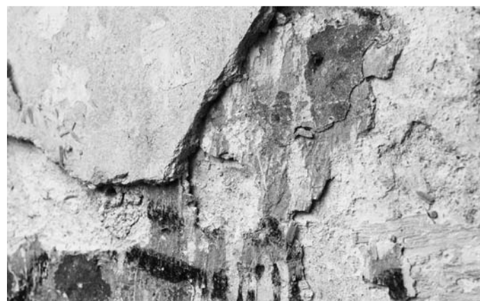
Abblätternde Putzschichten gefährden Wandmalereien – oft sind Salzausblühungen der Grund für Schäden an historischen Farbschichten
