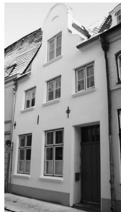
Stuckateure haben die barocke Straßenfassade per Hand mit Muschelkalk geputzt
