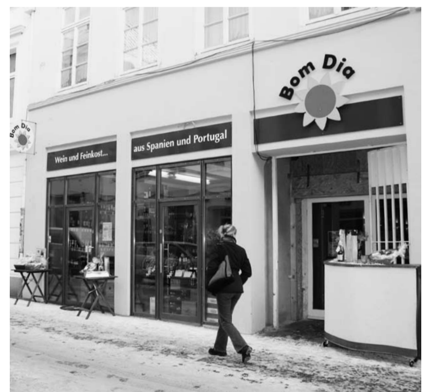
Direkter Zugang und bessere Wärmedämmung: Das Konzept für die neue Schaufensteranlage hat der Architekt zusammen mit der Stadtplanung Lübeck erarbeitet. Der Durchgang rechts bekommt noch das gleiche Fenster-Tür-Element
