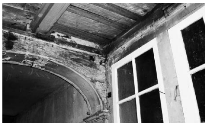
Unter die Holzschalung werden Gipskartonplatten frei schwingend montiert
