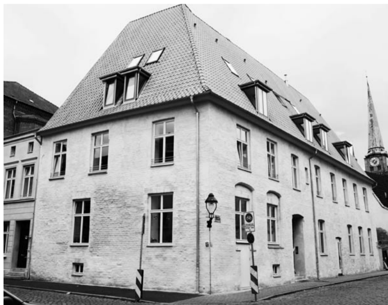
Die ehemalige Gertrudenherberge hat ein neues Satteldach nach historischem Vorbild bekommen, ergänzt mit modernen Glasgäuben
