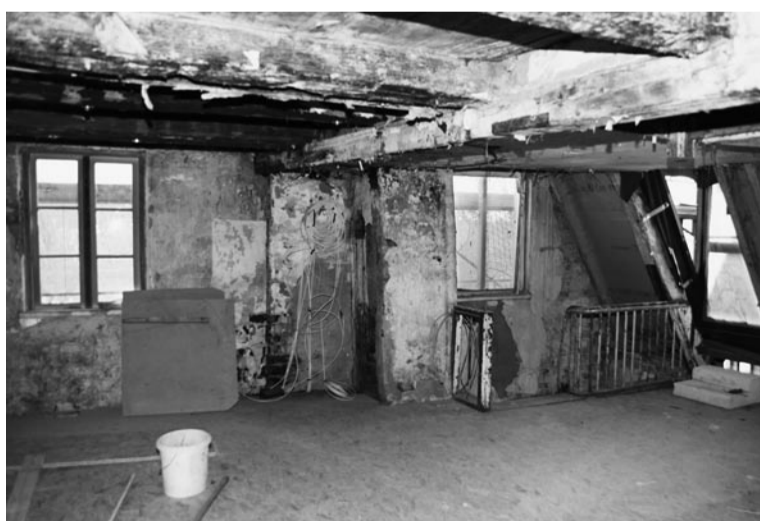
Das Dachgeschoss wird nach dem Umbau zum großen Wohnraum
