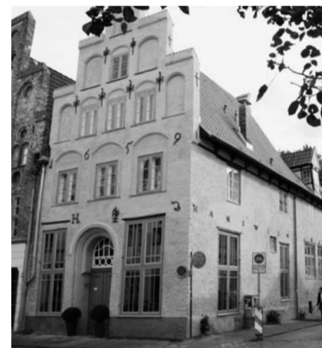
Das markante Eckhaus mit Renaissance-Fassade
