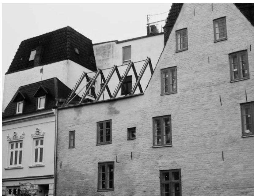
Kurz vor Fertigstellung fehlen nur noch die Lamellen auf dem Freisitz. Der Seitenflügel bekommt damit optisch seine ursprüngliche Dachform wieder
