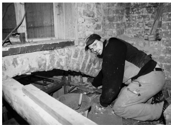
Sanierung der Rückwand: Provisorische Stützen sichern den Steinbogen während Martin Garglow ihn wieder untermauert
