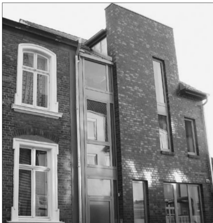
Ein Fensterband grenzt die moderne Fassade vom Nachbarhaus ab
