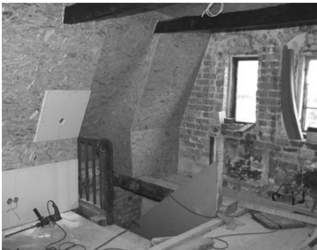
Das Dachgeschoss wird mit Platten aus Holz und Gipskarton verkleidet
