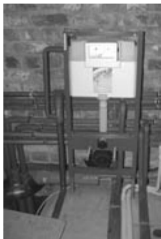
Versorgungsrohre verschwinden später hinter Wandverkleidungen
