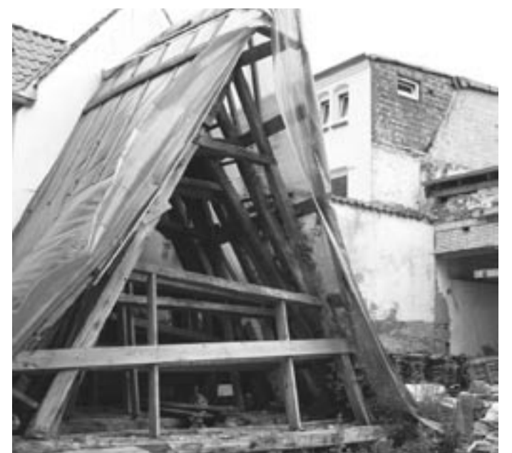
Provisorisch vor Regen geschützt: Dachbalken des Hinterhauses
