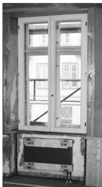
Innen modern, außen rekonstruiert: Die Außenfenster wurden originalgetreu nachgebaut, innen isolierverglaste Winterflügel eingesetzt
