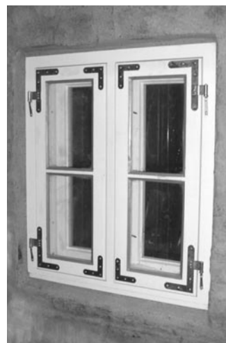
Auch im Seitenflügel gibt es Innen- und Außenfenster: So ist die Wärmedämmung garantiert
