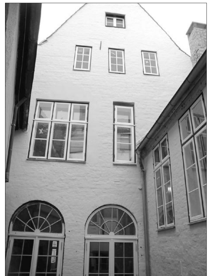
Die historischen Fensterformen auf der Rückseite wurden wiederhergestellt
