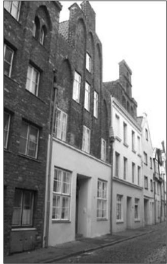
Historische Fassade: unten Putz, oben Backstein
