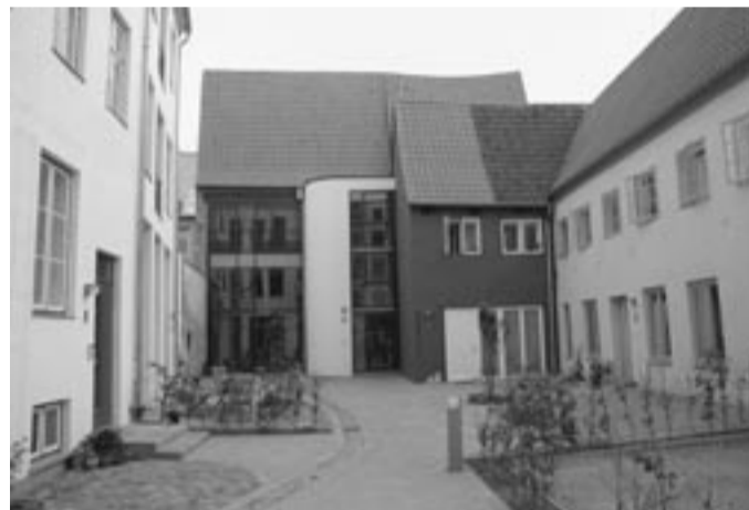
Vorher – nachher: Kaum wieder zu erkennen sind die Häusern der Fischergrube 84. Aus den verfallenen Gebäuden und Schuppen entstanden mit viel Liebe zum Detail zwölf moderne Einheiten zum Wohnen und Arbeiten.
