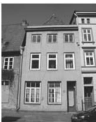
Wird saniert: Glockengießerstraße 97
