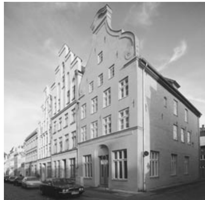
Das Gebäude hat auch wegen seiner Ecklage an der Glockengießerstraße / Ecke Tünkenhagen eine besondere städtebauliche Bedeutung. Umso wertvoller ist es, dass das nahezu abgängige Haus gerettet werden konnte
