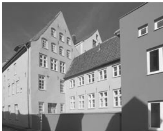
Glockengießerstraße 44: Die gelungene Kombination historischer Bausubstanz mit modernem Neubau überzeugte die Preisrichter
