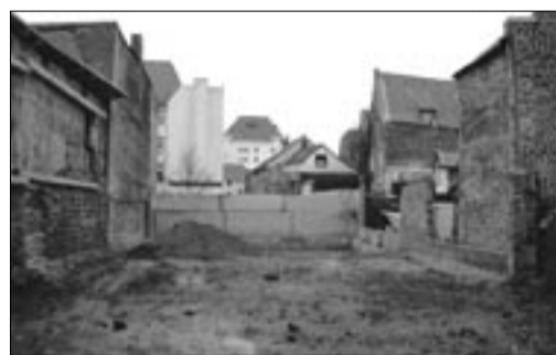
... und danach: Im Hof ist eine neue Freifläche entstanden
