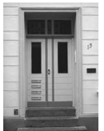
Auch kleinere Sanierungsmaßnahmen unterstützt die Possehl-Stiftung. Holz statt Aluminium: Hauseingang Große Gröpelstr. 13
