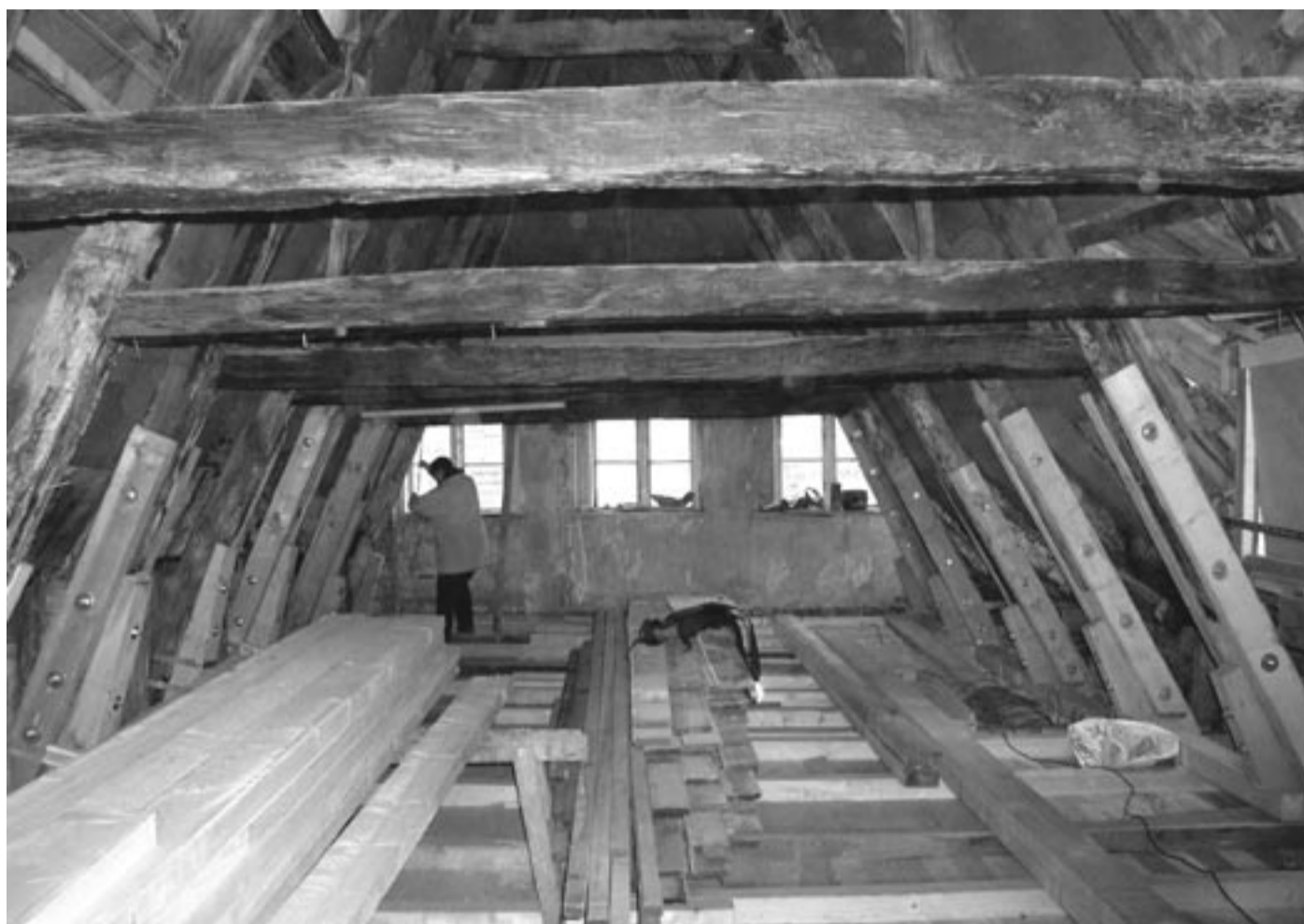
Auch der Dachstuhl wird aufwändig saniert
