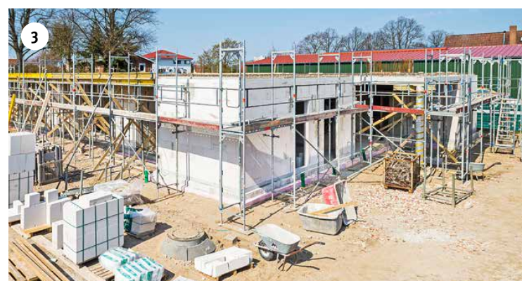
Hier entsteht die neue DRK-Kita im Neubaugebiet Rothebek.
