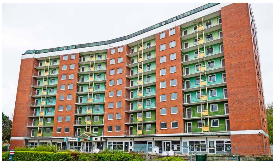
Ein ungewöhnter Anblick des Wohnhauses Sterntalerweg 1-3: Die Balkonbrüstungen sind im Frühjahr entfernt worden.
