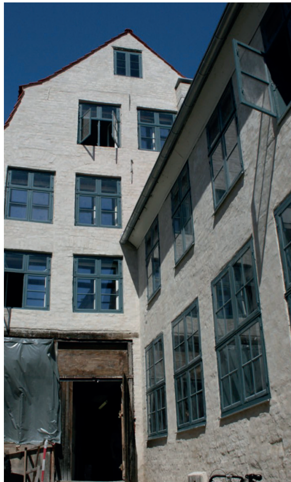
Hofansicht während der Sanierung
