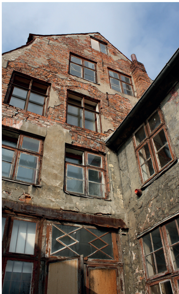
Hofansicht vor der Sanierung
