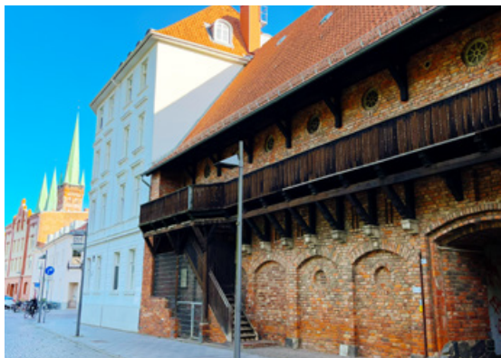
Der Hochbunker an der Obertrave tarnt sich als historisches Fachwerkhaus.
